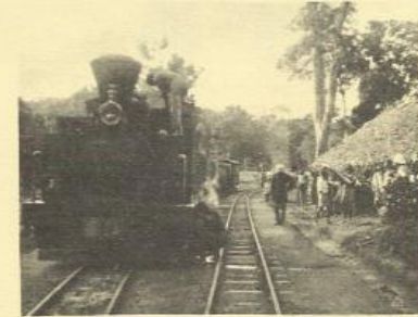
De la route au rail
